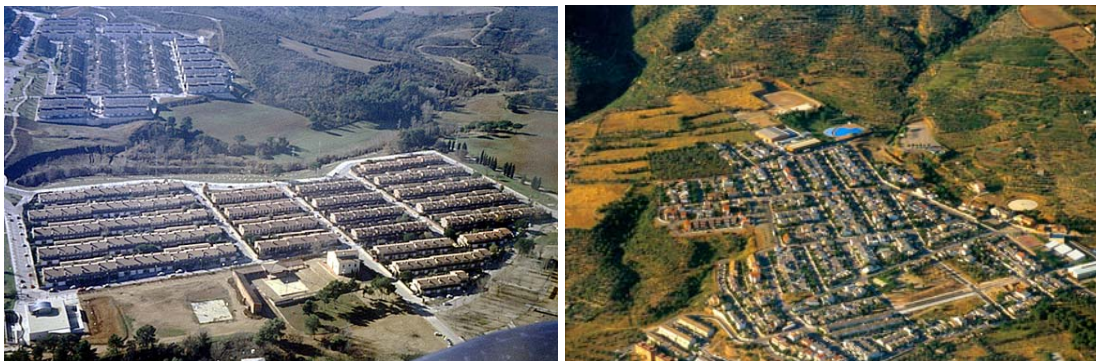
IMAGEN 8 y 8BIS. Residencias unifamiliares en la región metropolitana de Barcelona.
