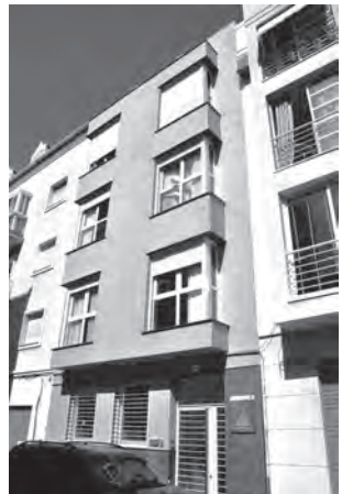
Ilustración 13. Sede de Diamondway en Málaga.
